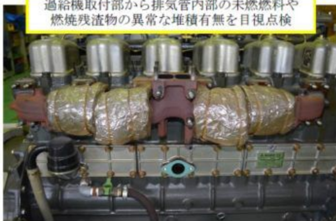
図2 排気管内部目視点検
